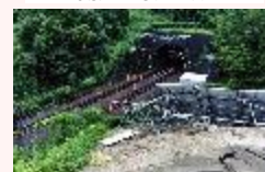
＜太陽光パネルの崩落＞
