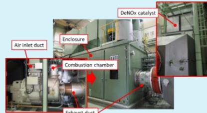
2MW級アンモニア混焼ガスタービン
