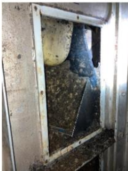
点検窓からの様子
