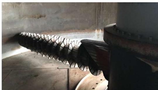
サービスバンカー内部状況
