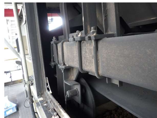
内部躯体状況
