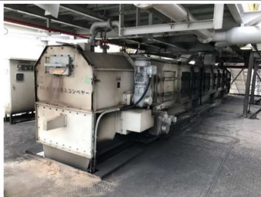
ケーシング変形
