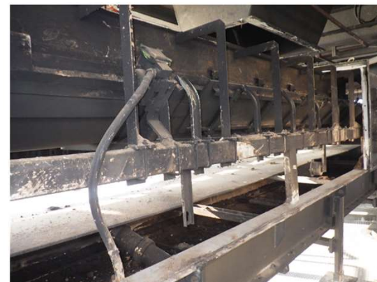
内部躯体状況
