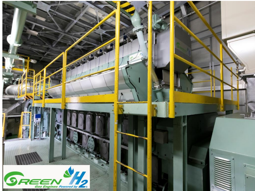
水素混焼に対応したガスエンジン外観
