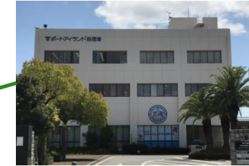
ポートアイランド 処理場
