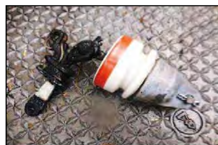
撤去した引留碍子 ※耐圧試験実施したが 異常なし
