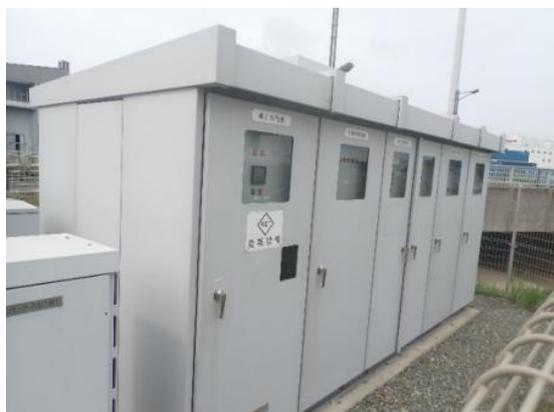
[図 1] キュービクル(高圧受電設備)
