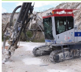
発破のための穿孔作業
