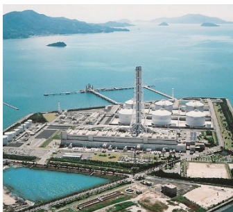
LNG火力発電所
